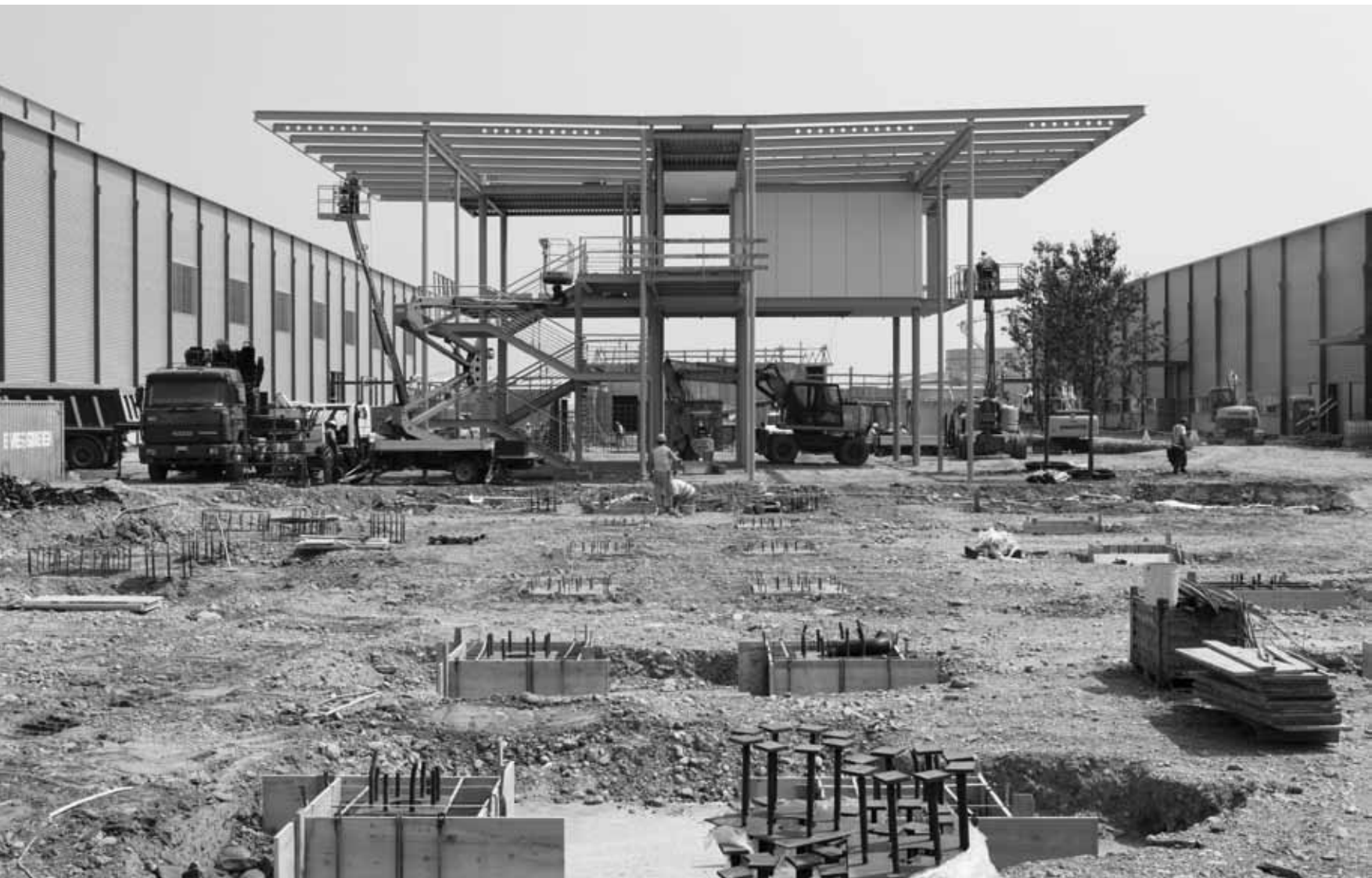
I lavori di realizzazione del polo industriale di Settimo Torinese
